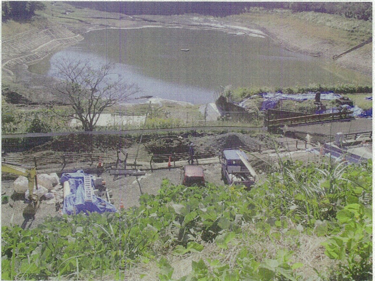
大切畑ダム現況 (H28.10.24 撮影)
