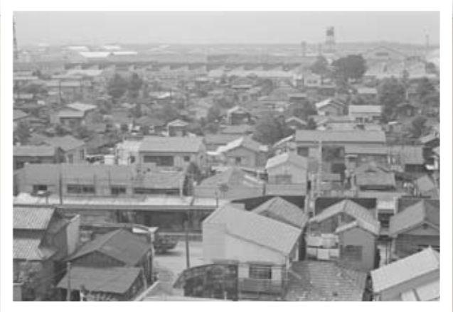
立川市砂川町の住宅街 1966年 (東京都提供)
