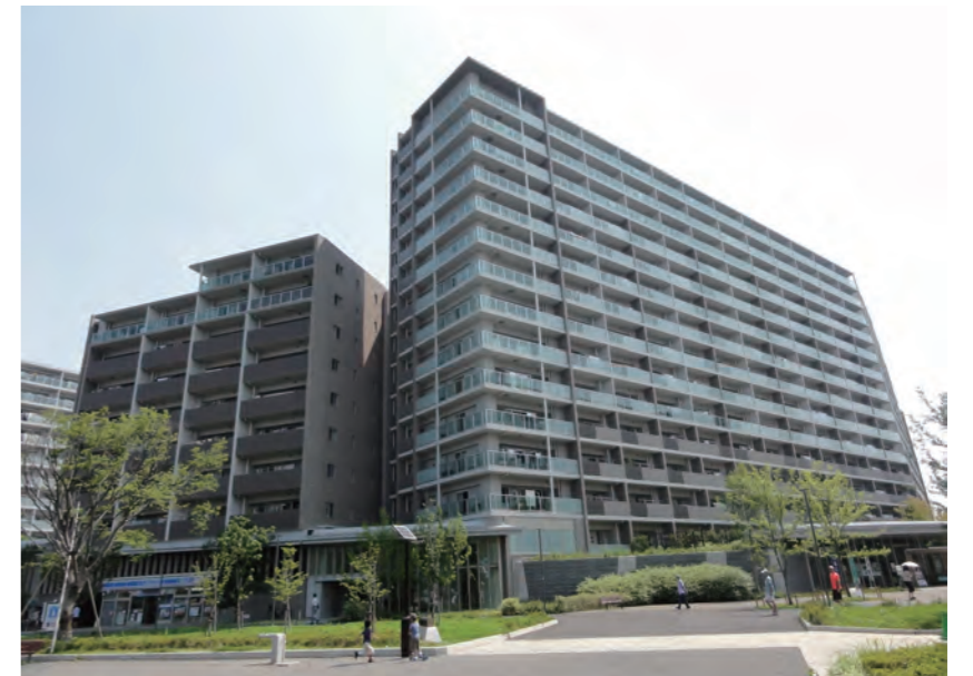
建て替えられた諏訪二丁目団地
