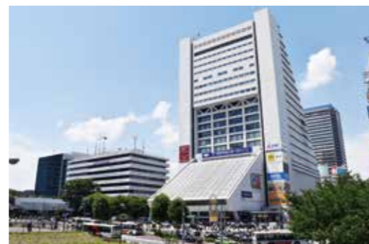
区役所・サンプラザ地区再整備は、中野区役所（左から2棟目）と中野サンプラザの敷地を合わせた約2haと中野駅新北口駅前広場を一体的に整備する計画となっている。
