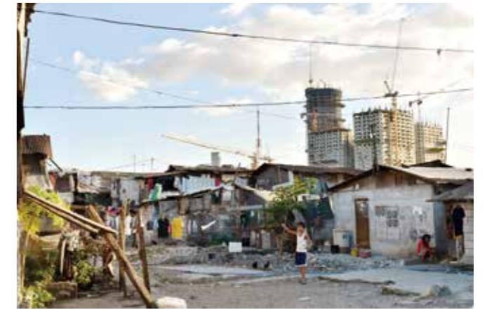
建設が進む高層マンションとその足元に広がるスラム
