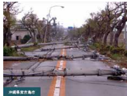
▲台風によって倒れ、道路をふさいだ電柱（出典：国土交通省HP）
