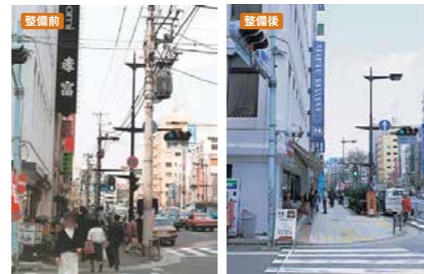
電柱地中化が実施された中央区日本橋馬喰町周辺の国道6号線 出典：国土交通省関東地方整備局HP
