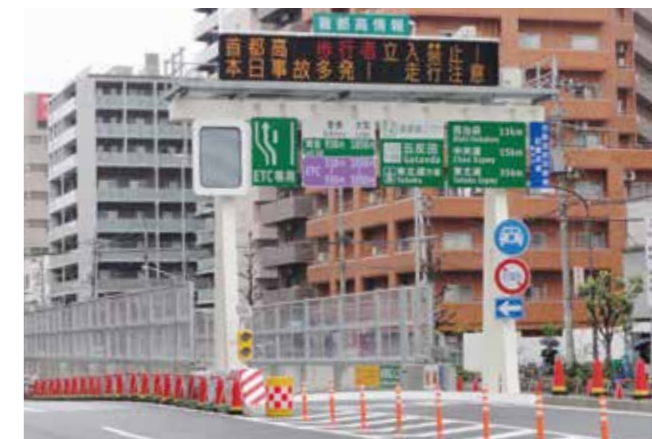
新規開通した山手トンネルの五反田入り口。大橋JCT方面への入り口となっています。
