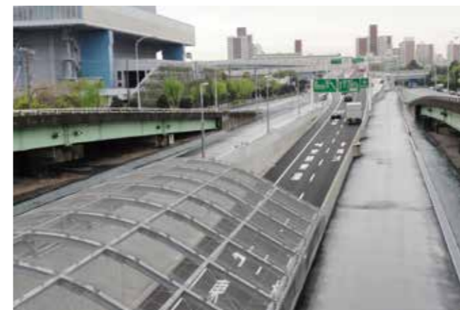
大井JCTの中環大井南出口方面。大橋JCT方面からの出口となっています。
