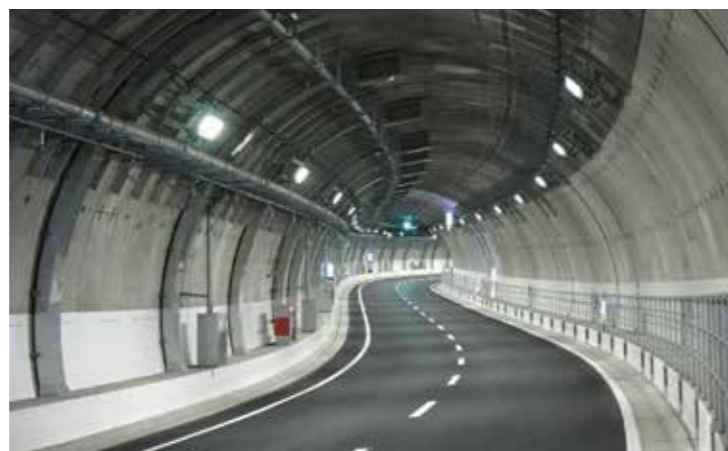
中央環状線山手トンネル
