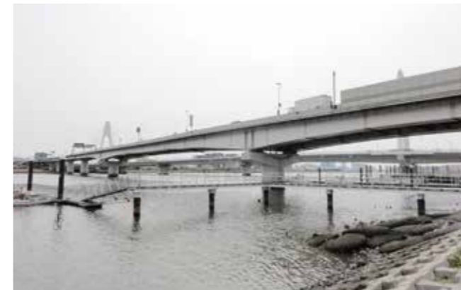
首都高1号羽田線の高速大師橋
