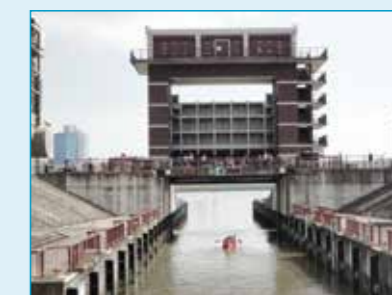
荒川ロックゲート
