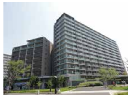
建て替えられた諏訪二丁目団地
