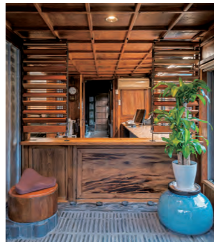
ルーバーを設置し、風通しを良くした
