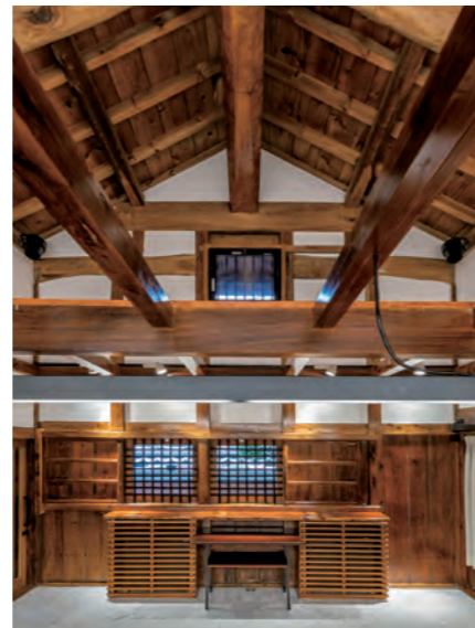
梁や天井をあらわにし、広がり確保
