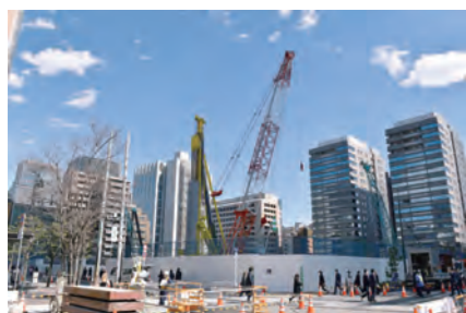
建設中の「(仮称)虎ノ門ヒルズ ビジネスタワー」(写真中央)にはBRTのターミナル設置が検討されている
