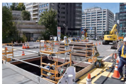
虎ノ門駅と虎ノ門新駅を結ぶ地下道周辺での工事
