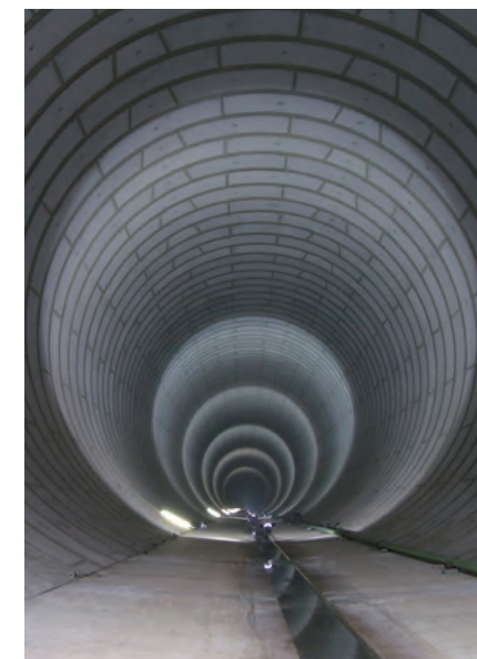
神田川・環七号線地下調節池の地下トンネル部分。内径12.5mのトンネルは約4.5kmにわたり、現在、更なる容量の確保のため延伸中 東京都建設局第三建設事務所提供
