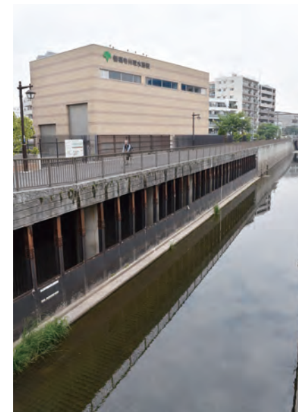
環七調節池の善福寺川取水施設。洪水時には左側の空間から地下に水を取り込む
