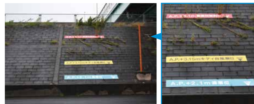
A.P.5.1mの高潮にも対応できる荒川（中川）左岸の堤防
