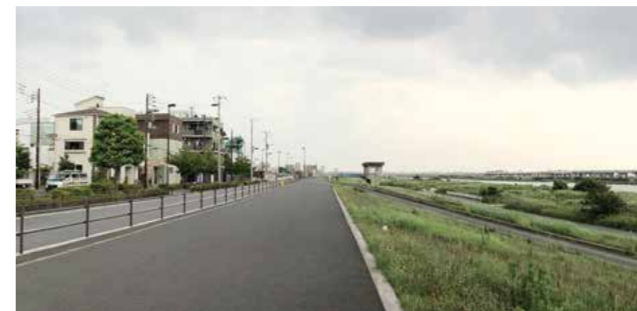
完成した高規格堤防により、かさ上げた住宅地（左側）は荒川（右側）の水面よりも高くなった（江戸川区平井七丁目地区）
