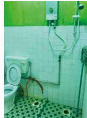
田舎の住宅のユニットバス。低い位置にホースが設置されているのはイスラム教徒が用を足した後に洗浄するため。お祈りに足を洗ったりするのに使う人もいるそう。
