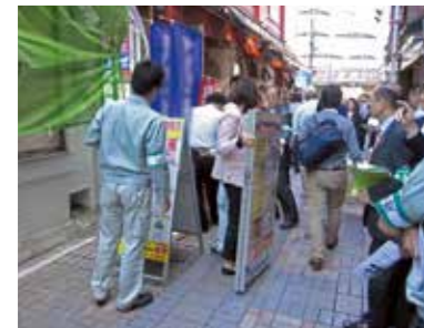
共同除却作業のようす
