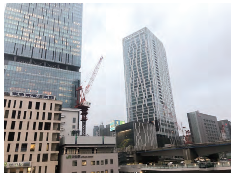
Googleが入居した渋谷ストリーム（右側）と、スクランブルスクエア東棟、手前の東急東横店には中央棟が建設中
