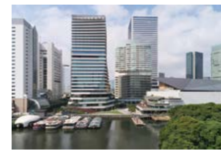
ウォーターズ竹芝(中央がオフィス棟、右側に劇場棟)
