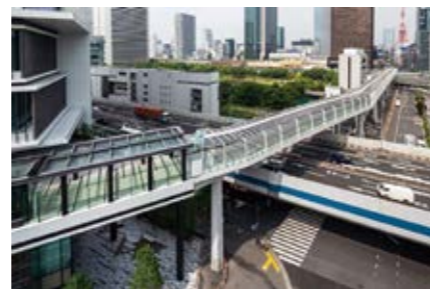
首都高速道路をまたいで浜松町駅から東京ポートシティ竹芝を結ぶ歩行者デッキ
