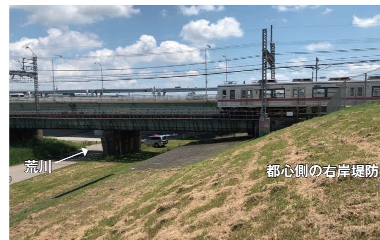
堤防にめりこむようにかかる京成本線の鉄橋。荒川は左手前から奥に流れる
