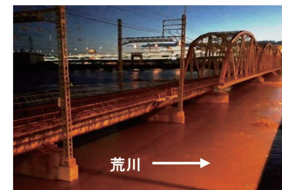
鉄橋の橋げたに迫った荒川の水面（国土交通省HPより）
