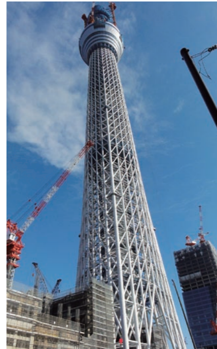
1 建設が進む 東京スカイツリー
