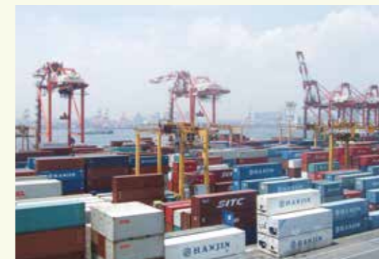
青海外貿コンテナターミナル
