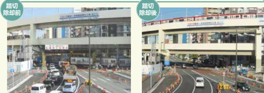
連続立体交差化された京浜急行線（第一京浜付近）
