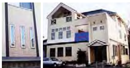
屋根の下に設けたユニオファットとダクト(写真上)にて、床に送風し床暖房をする自然型ソーラシステム(写真右)。断熱サッシと通気用二重外壁(写真左)
