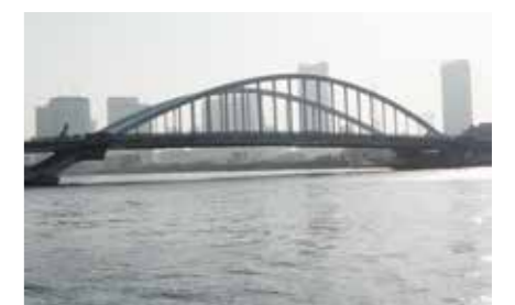
環二の隅田川橋りょう(仮称)
