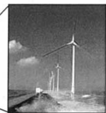
洋上風力発電施設
