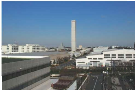
多摩地域の機械工場
