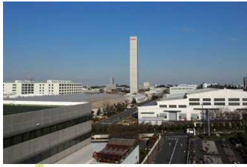
多摩地域の機械工場
