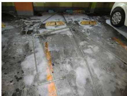
泡流出事故の例
