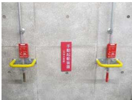
手動起動装置に保護ガードを設置
